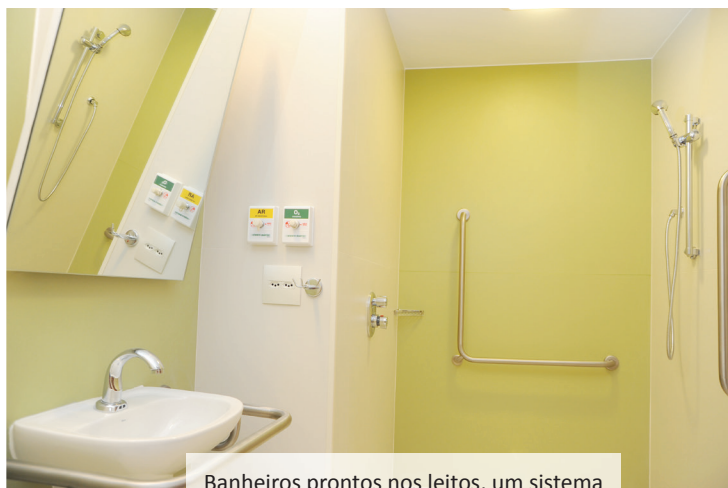
Banheiros prontos nos leitos, um sistema pré-fabricado que reduz o prazo da obra.
